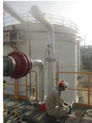
ปล่อง Charcoal Adsorber 2 (V-4102)
